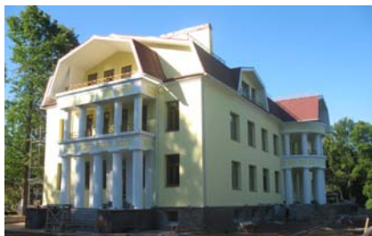
Реконструкция здания на Крестовском пр., 21
